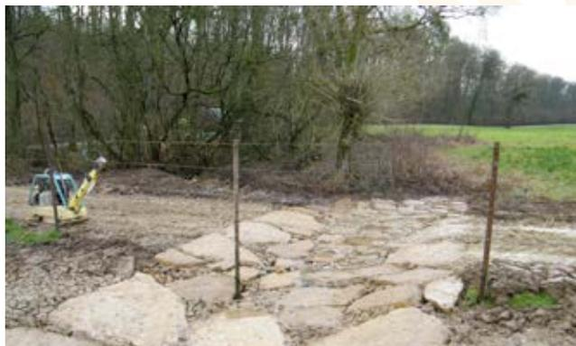
Bei der Restaurierung eines 65 m langen Abschnittes eines Baches in Mompach wurden 100 m Betonrohr entfernt und Furten angelegt.
