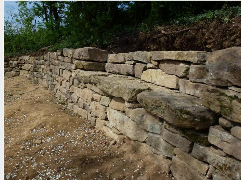
Chantier de restauration d'un mur de vignoble. L'ancien mur était irrécupérable car trop envahi par la végétation. Un nouveau mur a été créé devant l'ancien de façon à restabiliser le talus. Mur avec courbure pour permettre au vigneron de circuler avec les machines.
